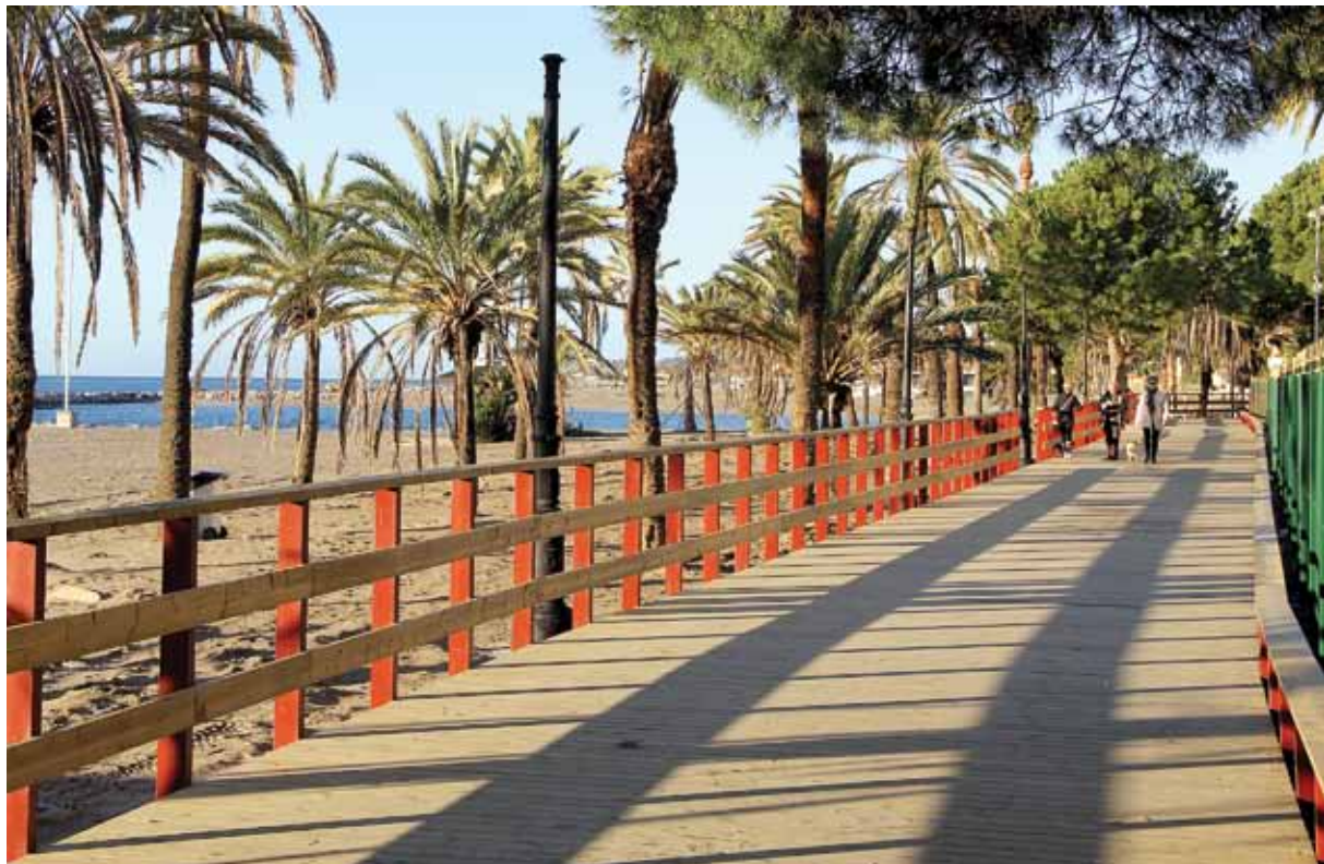
Gångdäcket väster om Puerto Banús blev klart på tre veckor i januari. Nu ska Martinssons uppföra två broar och ytterligare 400 meter gångdäck vid Rio Real och intill Antonio Banderas sommarhus, lagom till påsk.
