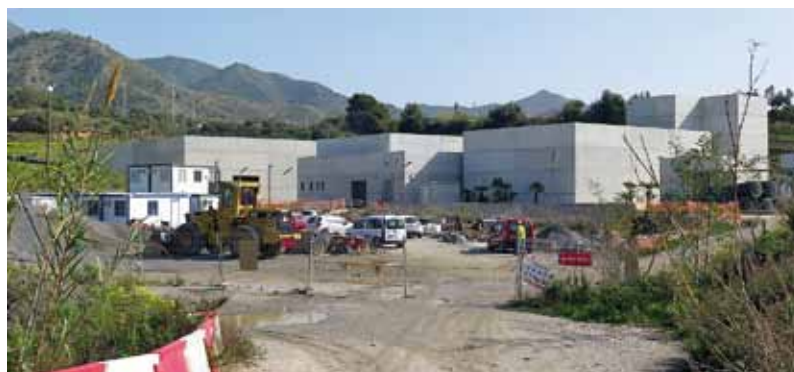
Efter att ha stått still i ytterligare nio månader återupptogs arbetet på reningsverket i Nerja i januari.
