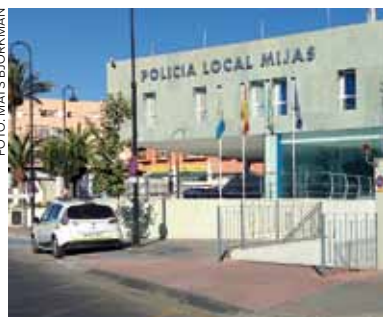
Polishuset i Las Lagunas framhålls som ett skräckexempel på bristfällig arkitektur mot jordskalv.
