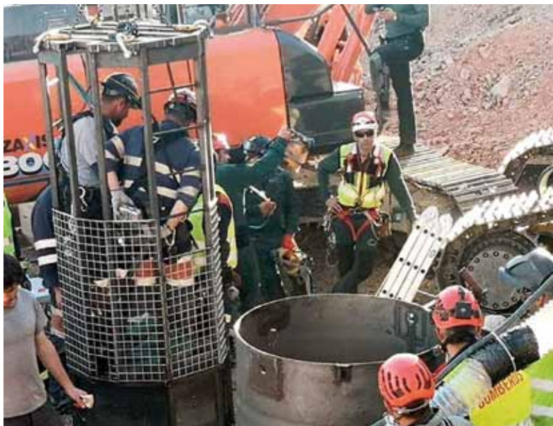
Gruvspecialisterna tog sig ned i räddningsbrunnen i en för ändamålet specialbyggd kapsel.
